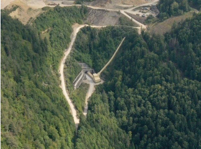
Abbildung 14: Beispiel einer Materialförderanlage (Rohrgurtt Förderer im Steinbruch Tscharnner, Péry - La Heutte)
